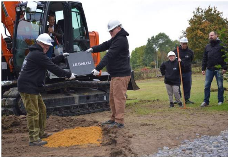
Des résidents du « Bailou » ont réalisé les travaux préparatoires et la pose du « premier pavé » de « leur » sentier.
